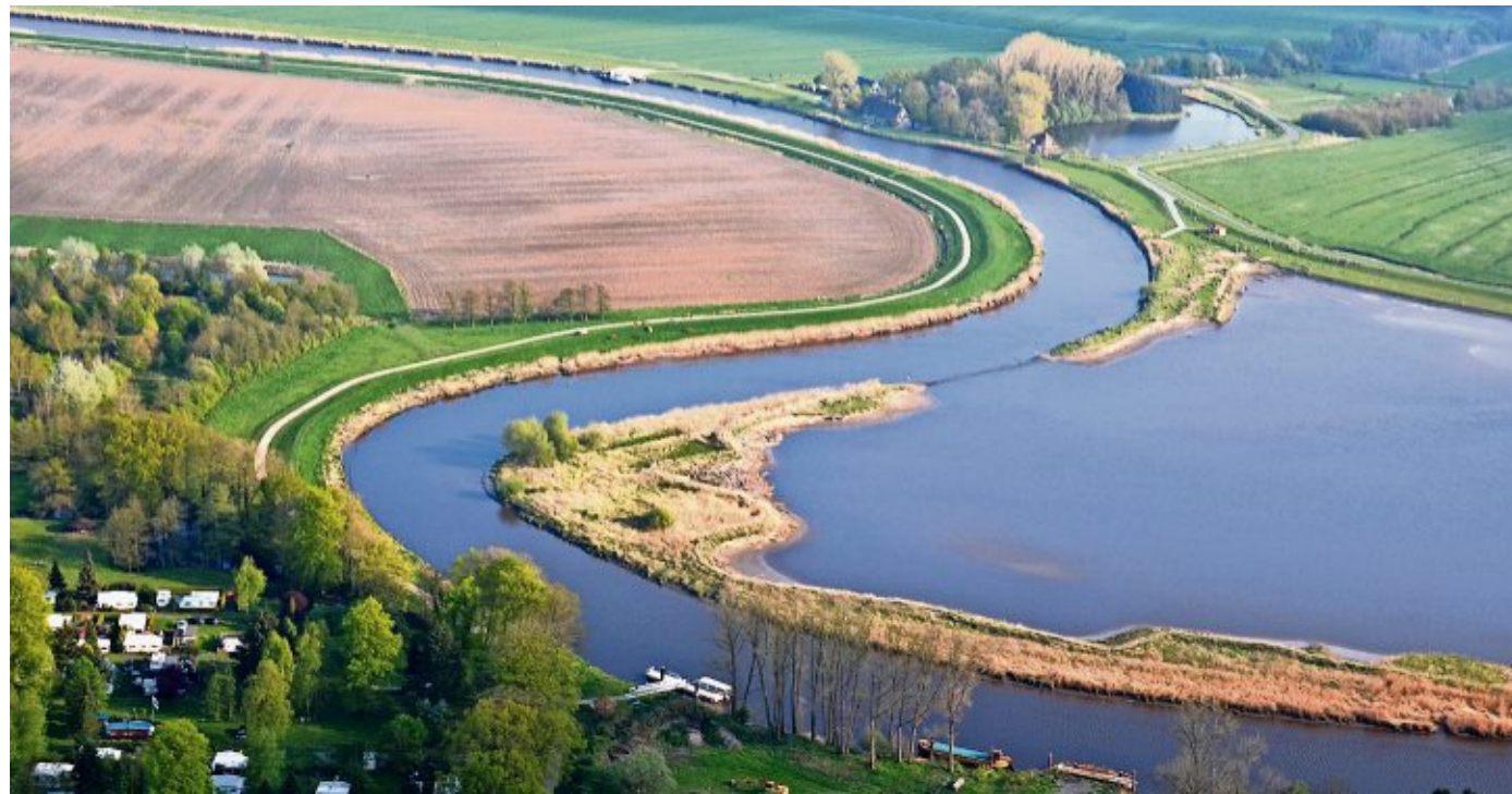
Die Oste bei Neuhaus: idyllisch, doch bei hohen Wasserständen auch anfällig für Überflutungen. Um derartige Situationen zu vermeiden, kümmert sich der Ostedeichverband um die Pflege der Deiche. ARCHIVFOTO: SCHRÖDER
